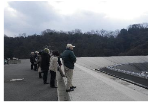
埋立処分場は臭いもなくクリーンです！
