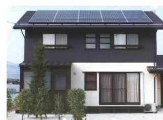
補助金を活用して設置された 太陽光パネル
